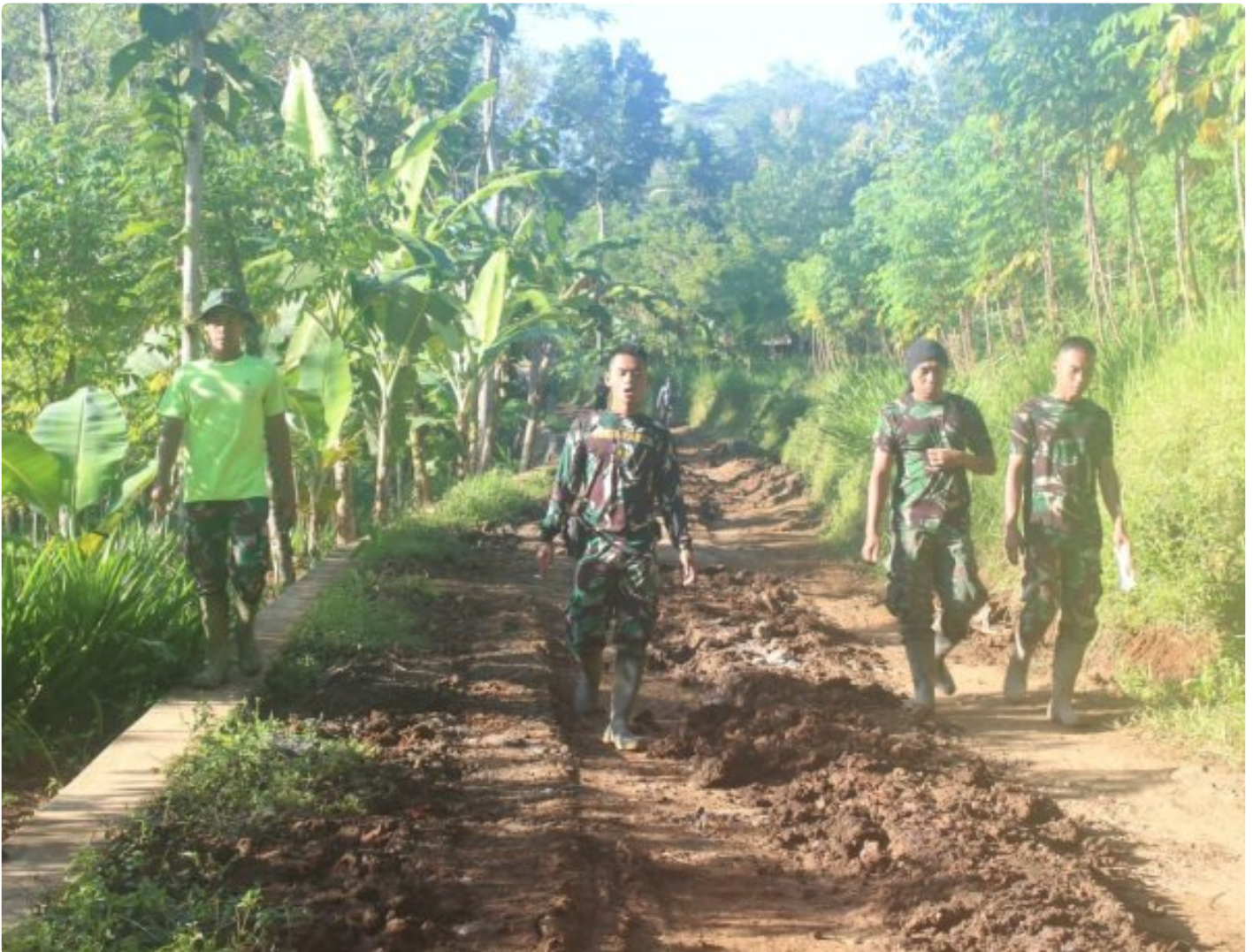
Anggota satgas TMMMD ke-116 Nampak bergegas menuju sasaran pengerjaan fisik
