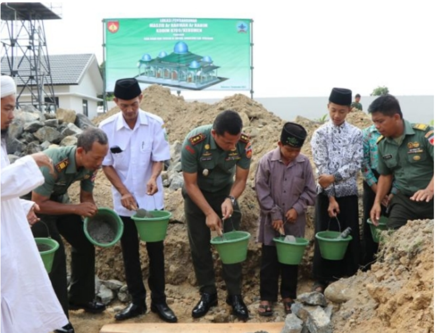
Peletakan batu pertama pembangunan masjid oleh Dandim 0709/kebumen Letkol Eduar Hendri S.I.P.
