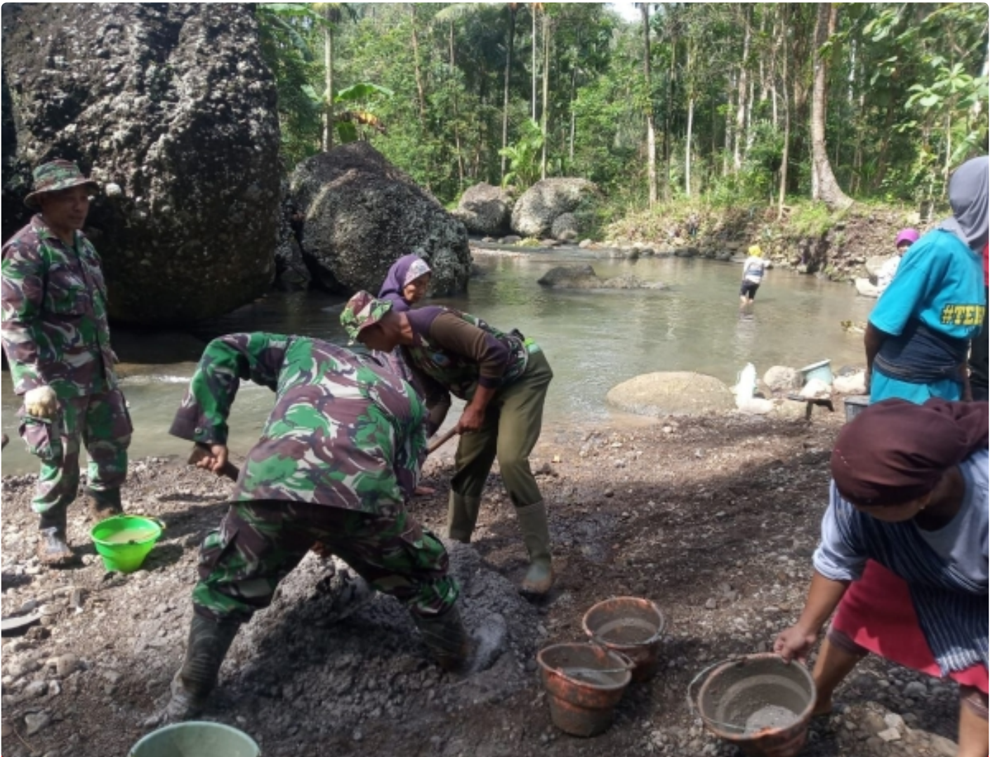
Serma Tugino bersama warga Desa Argosari, bahu membahu bergotong royong membuat talud penahan bahu jalan sepanjang 250 meter
