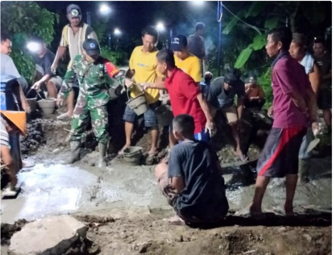
Babinsa Koramil 19/ Kuwarasan Bantu Pengecoran Jembatan Di Desa Binaan
